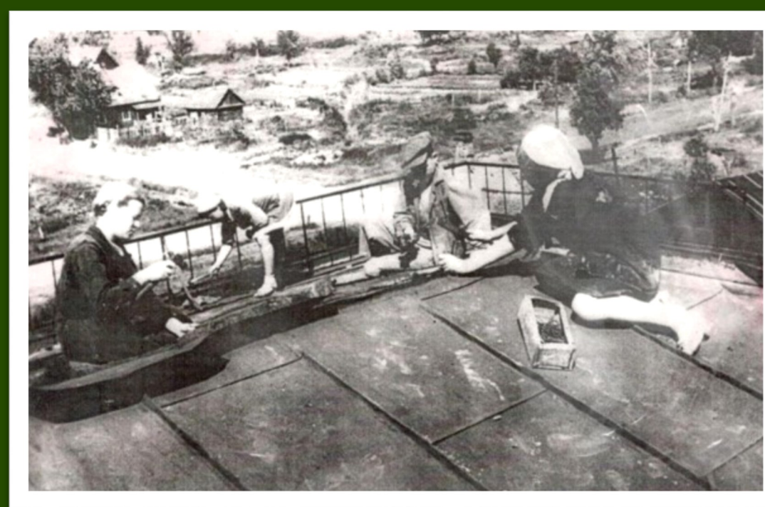
Ремонт кровли школы 402/400, 1944 г. (ныне здание Дворца творчества)
